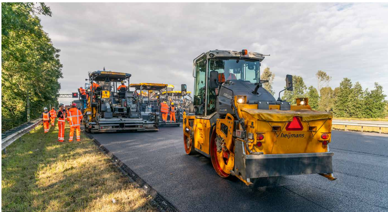
Asfalteren en walsen rijbaan op A12
