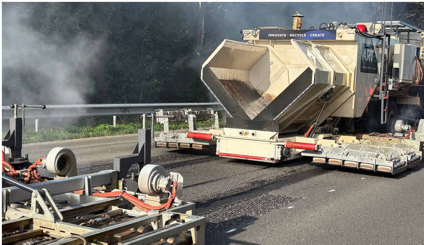
Asfalt Recycling Train in actie voor duurzaam wegonderhoud
