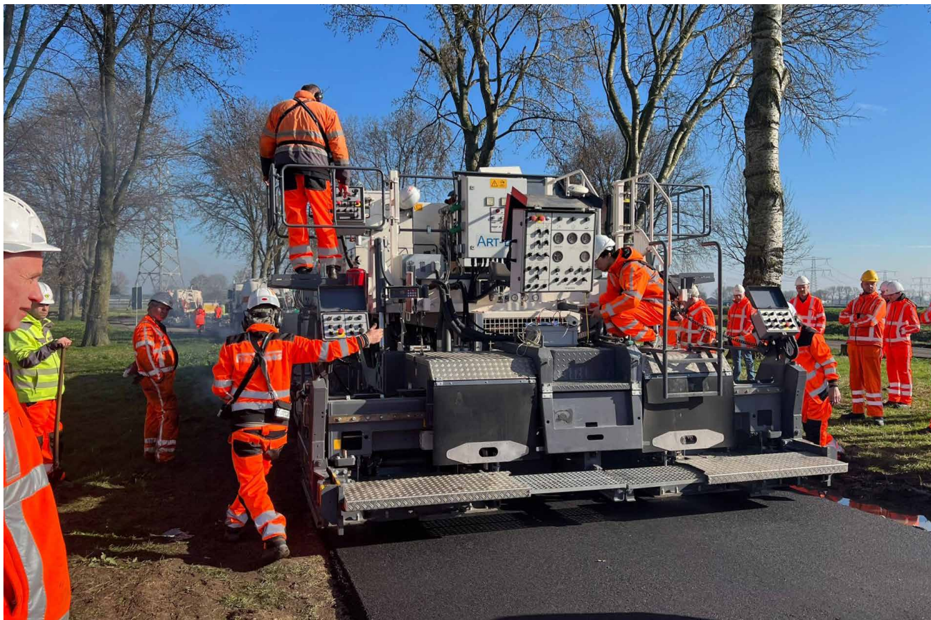
De inzet van de ART helpt bij vrijwel volledig circulair wegdekonderhoud, al het materiaal wordt opnieuw gebruikt
