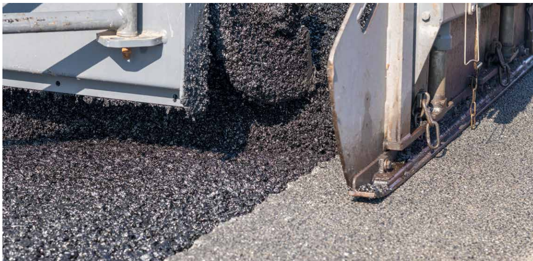
Detailbeeld spreidmachine - aanleg nieuw asfalt
