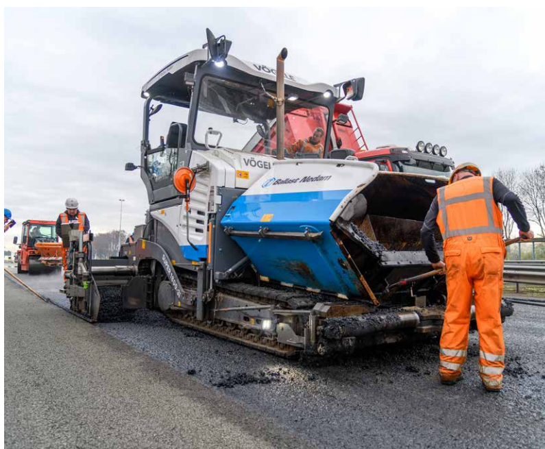
Asfaltspreidmachine - asfaltherstelwerkzaamheden op de A27
